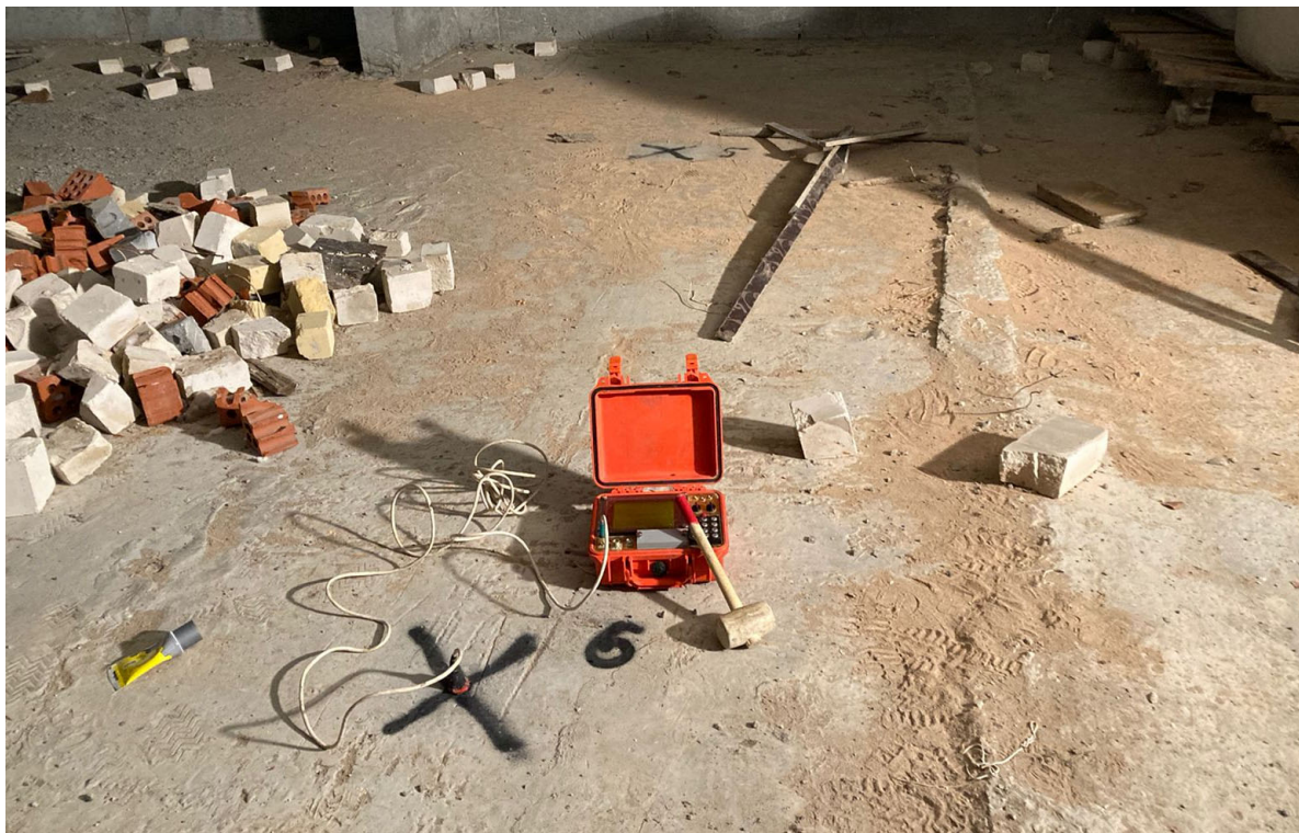
Рис. 1. Акустическое обследование фундаментной плиты.
